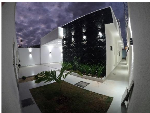
Figura 3: Fachada frontal do Caso B
