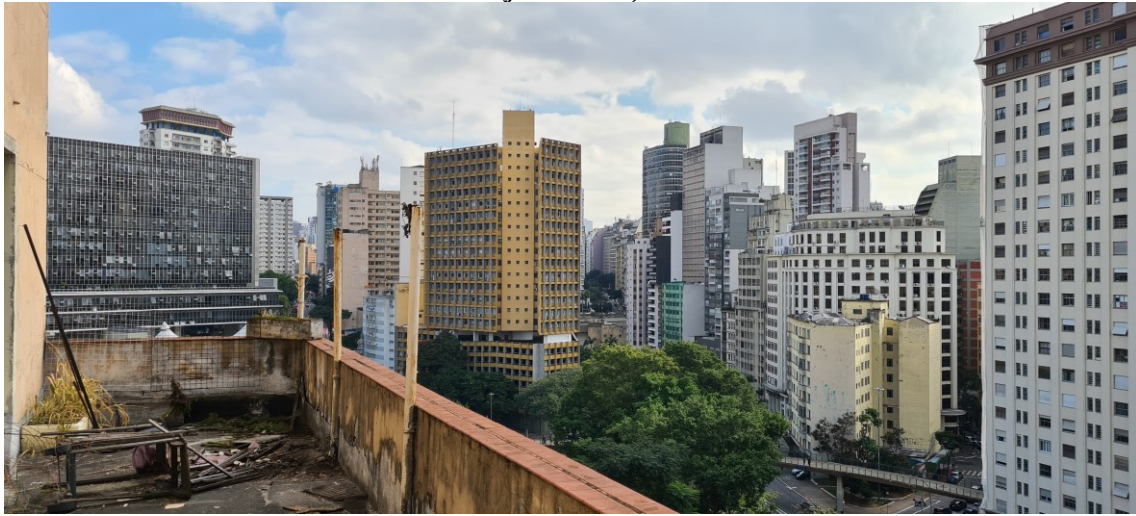
Figura 2: Vista de uma das futuras varandas em apartamento do Ed. Bandeira (junho/2021)
