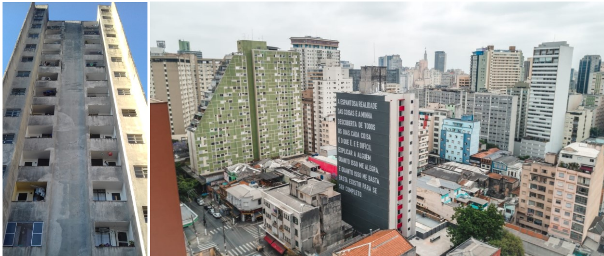
Figura 3: Edifício Pessoa antes (à esquerda) e depois (à direita) do retrofit.
