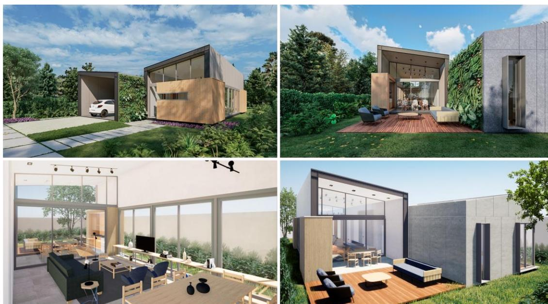
Na Fig. 12 observa-se, na fachada, com aspecto amadeirado, painéis isotérmicos utilizados em parte da vedação externa. Em cinza, a vedação externa é composta por placas cimentícias. No projeto em questão, pretende-se explorar as juntas, tratadas com selante elastomérico apropriado, como elemento arquitetônico.
