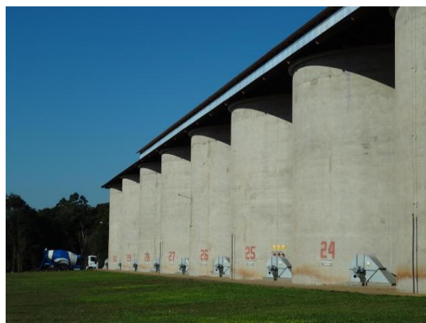
Figura 6 Silos elevados de concreto
