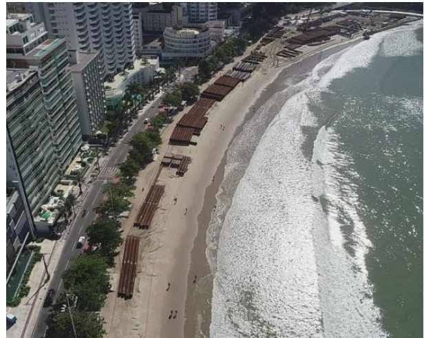
Figura 7: Obras de ampliação da faixa de areia
