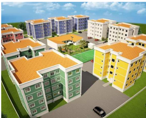
Figura 4 Empreendimento verticalizado Fonte Arquivo Pessoal
