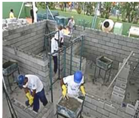
Figura 5 Construção em alvenaria armada Fonte Arquivo Pessoal
